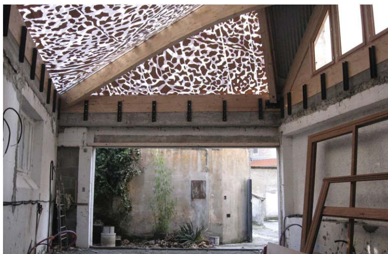
Figure 24: Structure primaire bois réalisée au sein de la Maison Duong 2 Philippe Villien
