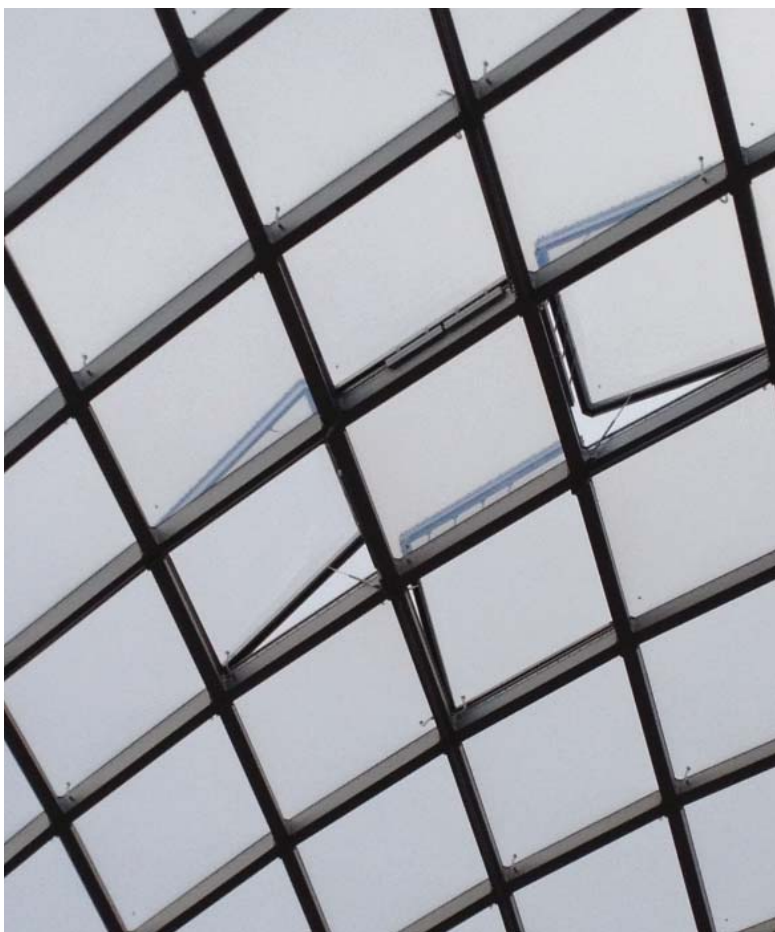
- Vue des ouvrants- Photographie personnelle
