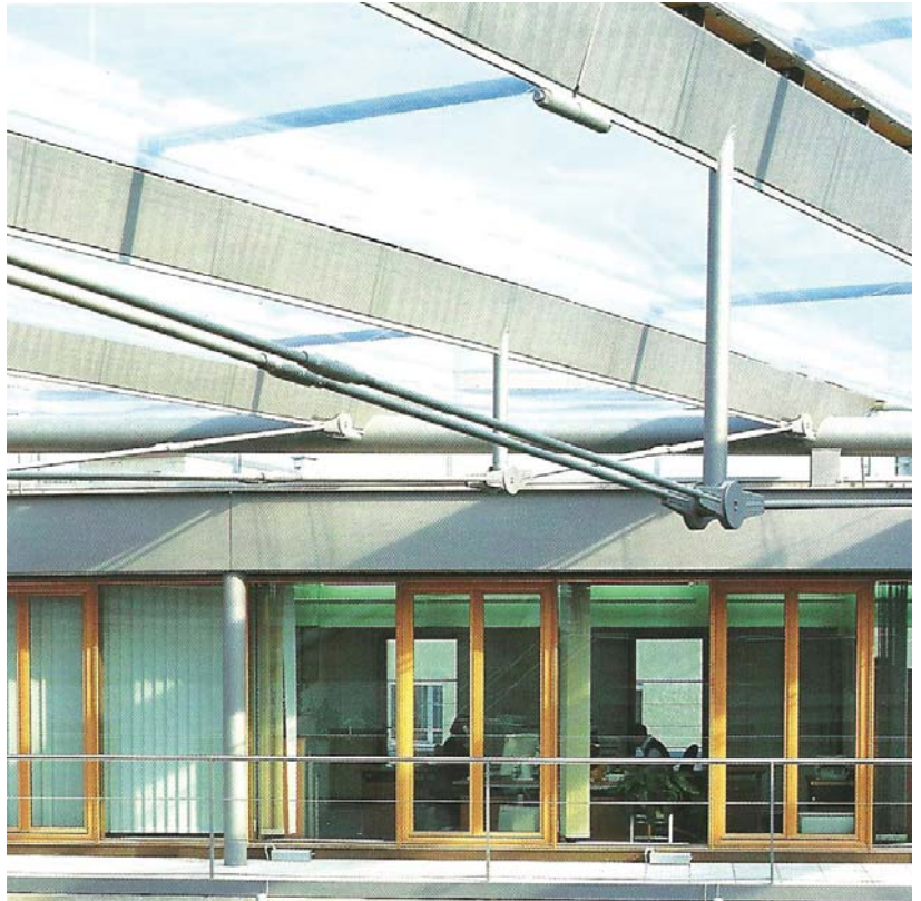
- Vue de la structure porteuse - Verwaltungsgebäude in München, Bauen mit Membranen, DETAIL 2000/6
