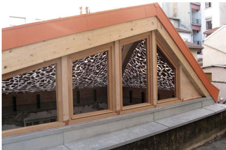
Figure 45: Ventilation naturelle de la Maison Duong 2 - Philippe Villien
