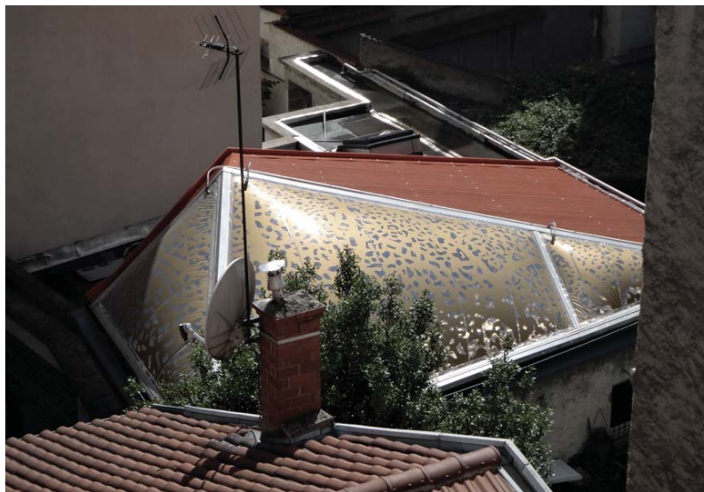
- Vue de la toiture réhabilitée - www.th1-agence.fr
