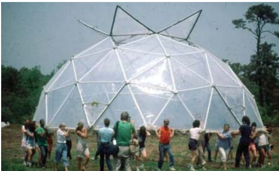
Figure 4: Vue du projet Pillow Dome
