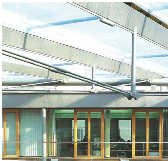
Figure 35: Vue des poutres triangulaires du complexe de bureaux VIAG AG
